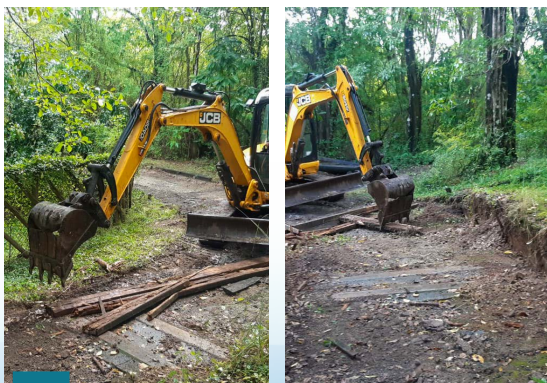
fig.95 Opération extraction des murets et reprofilage des berges, en février 2023
