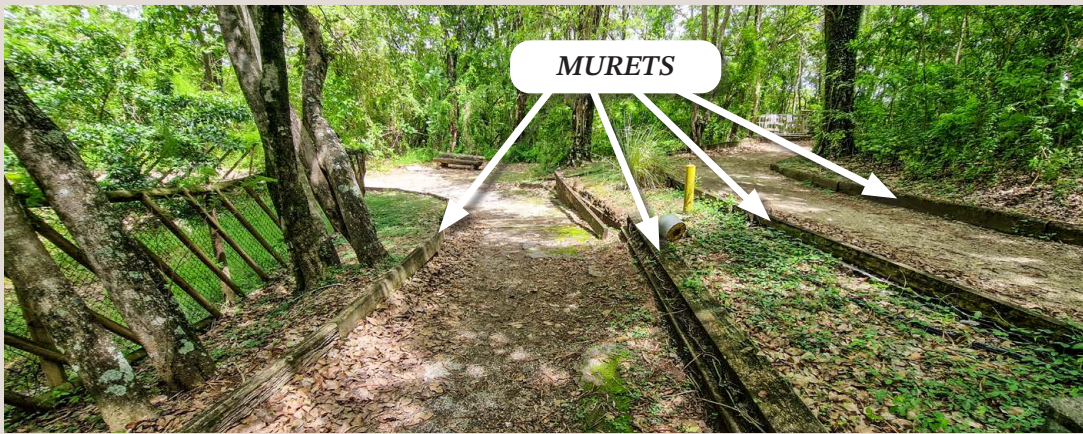
Sur cette mare les eaux de ruissellements étaient déviées par des murets en bordure de sentier, empêchant le rechargement de la mare en eau.
